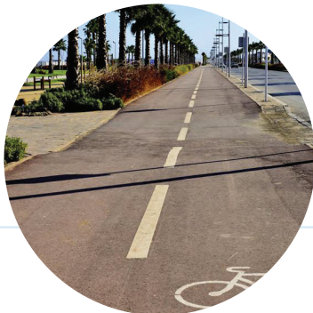
Aménagement d'une piste cyclable sécurisée. Corniche de Nador ©Agence de l'Oriental
